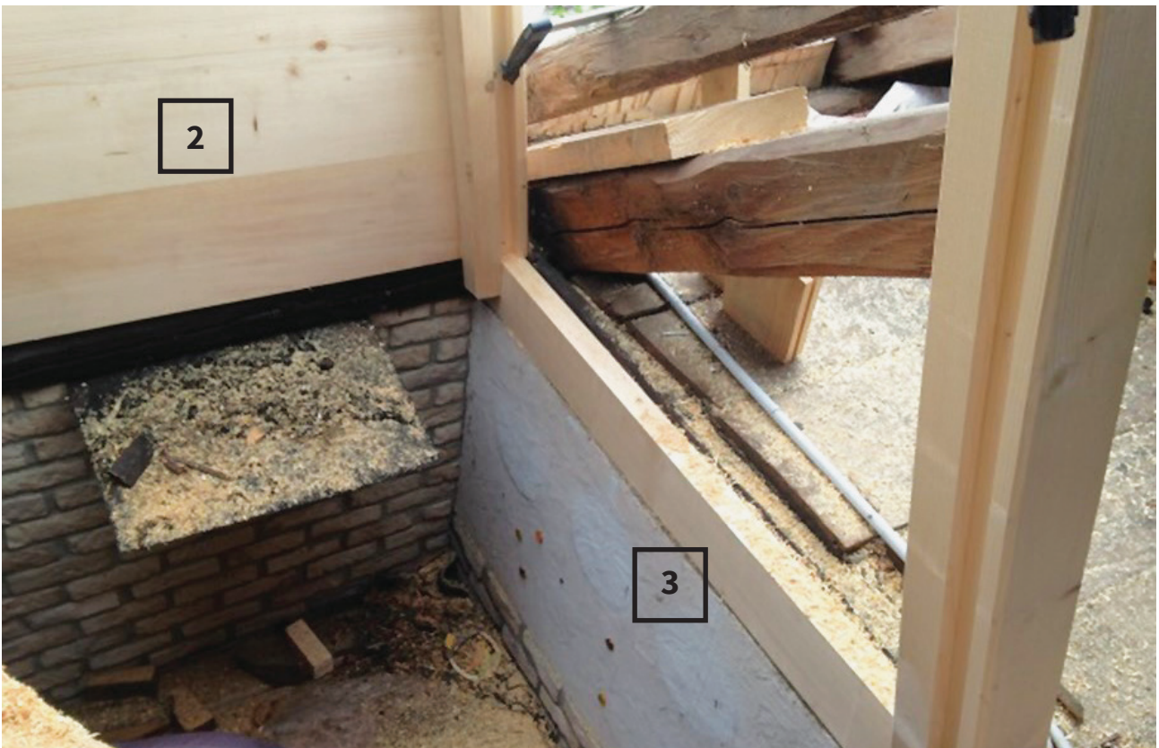
Holzkamin im Bau
