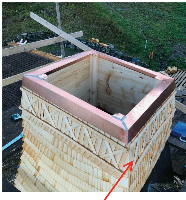
Quer- und Zierleisten entfernen
